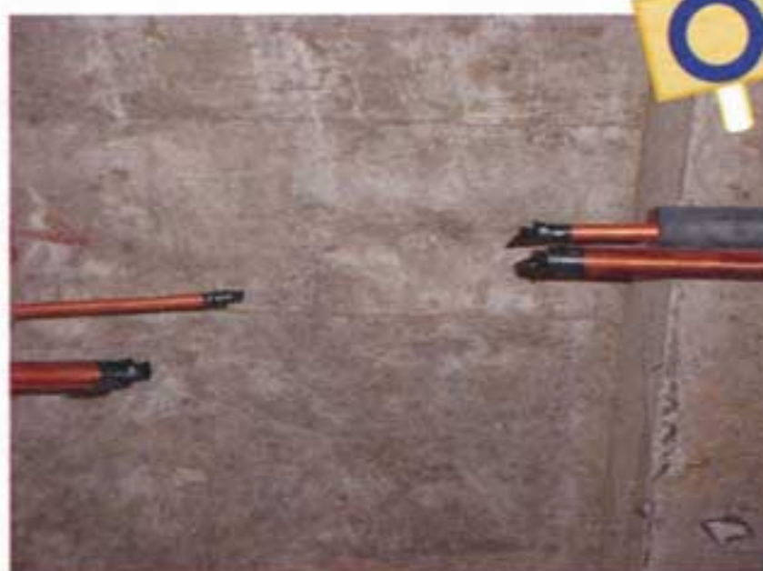
< Đầu ống được bảo vệ (bọc kín) >
