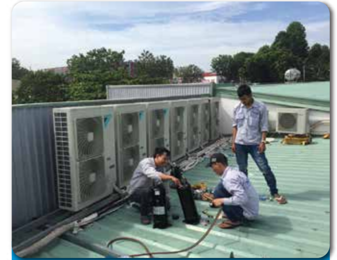
Dự án: DỊCH VỤ THAY MÁY NÉN, SỬA MÁY LẠNH ẨM TRẦN DAIKIN
