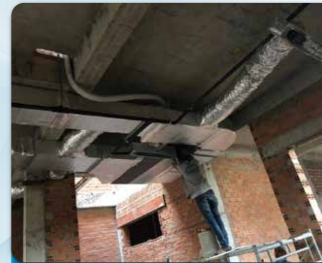
Dự án: THI CÔNG MÁY LẠNH GIẤU TRẦN NỐI ỚNG GIÓ CHO KHÁCH HÀNG TẠI ĐỒNG NAI
