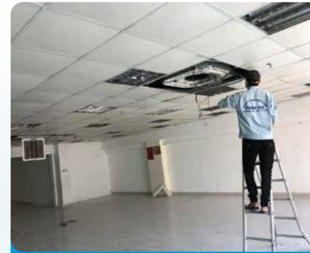
Dự án: BẢO TRÌ MÁY LẠNH TRUNG TÂM CHO TÒA NHÀ 27B NGUYỄN ĐÌNH CHIỂU, QUẬN 1
