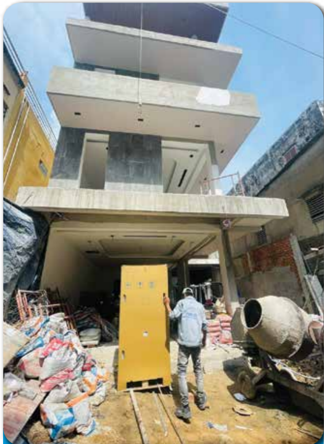
Dự án: THIẾT KẾ THI CÔNG MÁY LẠNH TRUNG TÂM VRV BIỆT THỰ CAO CẤP - QUẬN PHÚ NHUẬN
