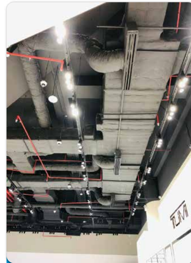
Dự án: THI CÔNG HỆ THỐNG LẠNH TRUNG TÂM CHO CHUỖI THỜI TRANG
