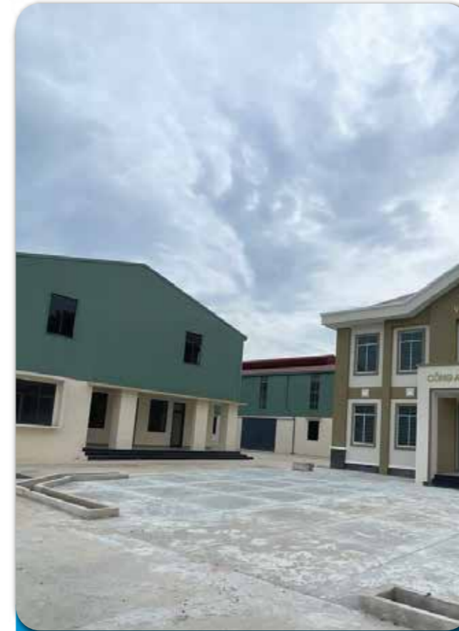
Dự án: THI CÔNG HỆ THỐNG PHÒNG CHÁY CHỮA CHÁY - CÔNG AN XÃ BÌNH MINH - TÂY NINH
