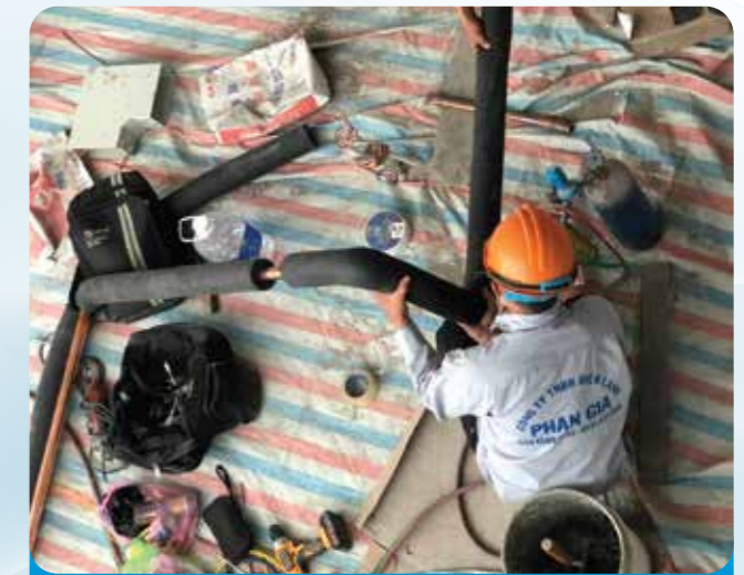
Dự án: THI CÔNG ỚNG ĐỒNG CHO HỆ THỐNG LẠNH TRUNG TÂM VRV
