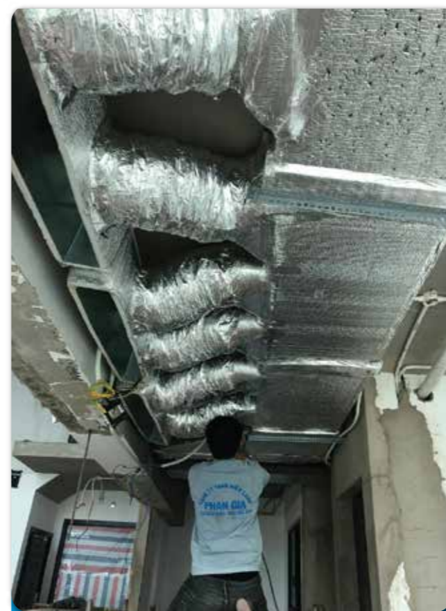
Dự án: CUNG CẤP, THI CÔNG MÁY LẠNH GIẤU TRẦN NỐI ỐNG GIÓ
