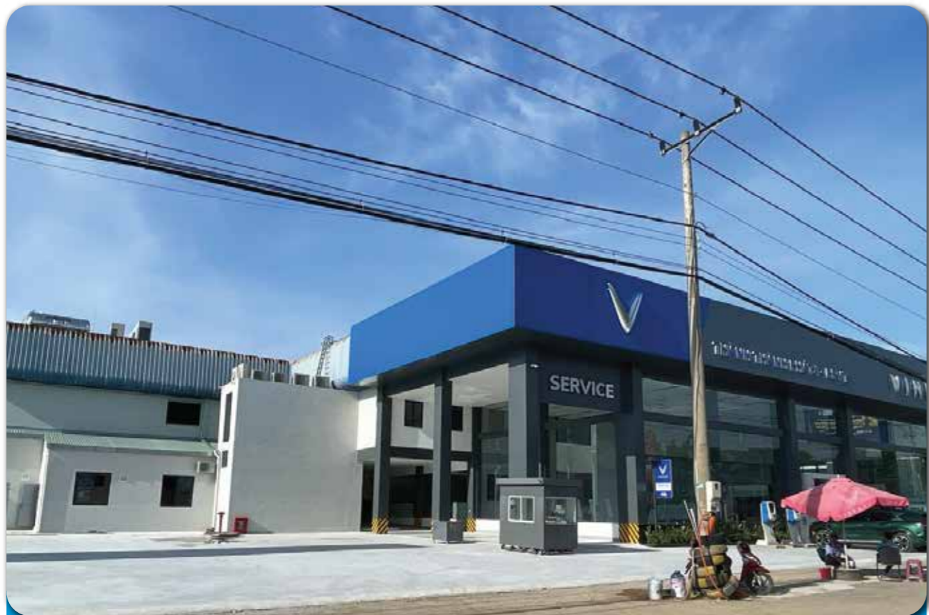
Dự án: THIẾT KẾ THI CÔNG MÁY LẠNH TRUNG TÂM VRV 120HP CHO VĂN PHÒNG, SHOWROOM VINFAT - BÀ RỊA VŨNG TÀU
