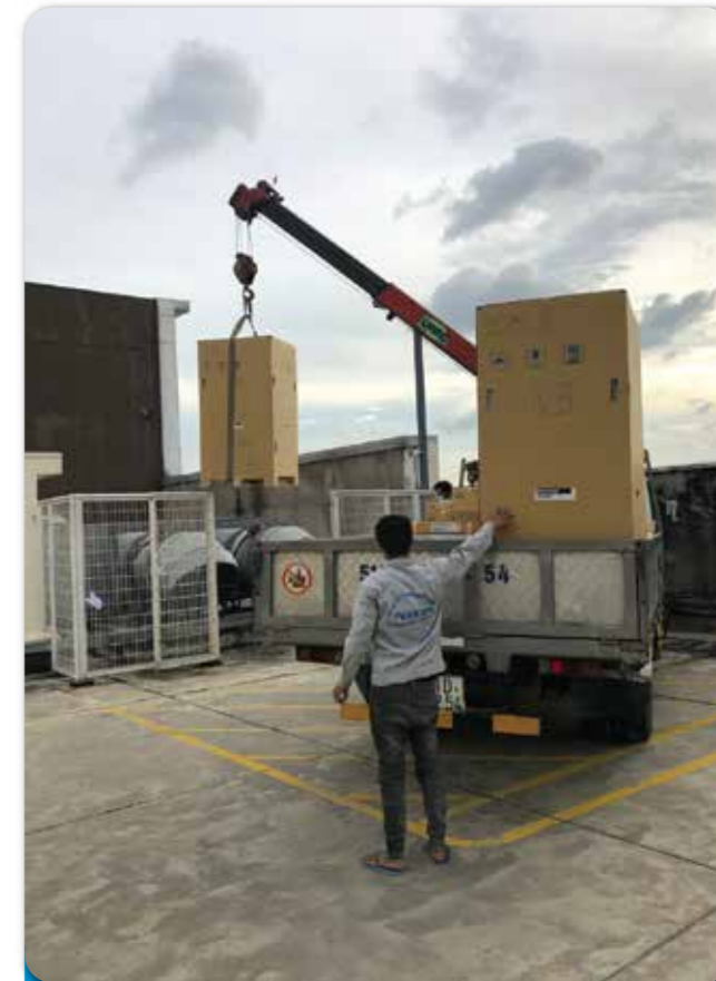
Dự án: CUNG CẤP, THI CÔNG MÁY LẠNH VRV A
