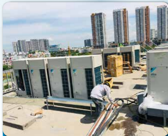
Dự án: THIẾT KẾ, THI CÔNG MÁY LẠNH TRUNG TÂM VRV A CHO SHOWROOM
