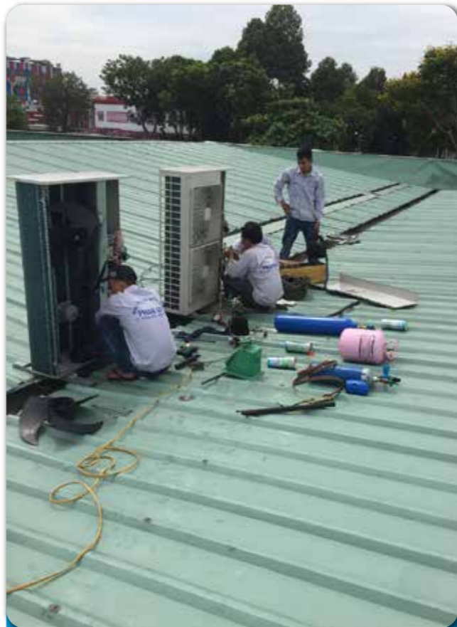
Dự án: SỬA CHỮA, THAY MÁY NÉN, MÁY LẠNH ẨM TRẦN CHO SHOWROM ÔTÔ ANYCAR VIỆT NAM
