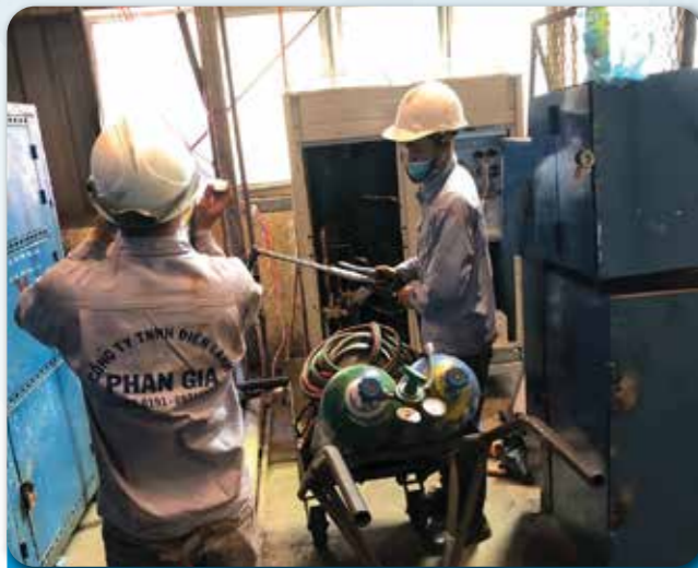
Dự án: THI CÔNG MÁY LẠNH TRUNG TÂM CHO NHÀ MÁY SATEX
