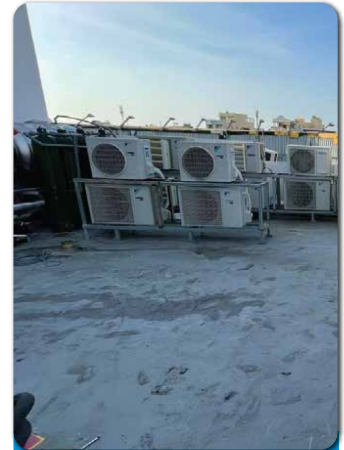
Dự án: THIẾT KẾ THI CÔNG MÁY LẠNH TRUNG TÂM VRV 46HP CHO KITTY BAR - TP BẠC LIÊU
