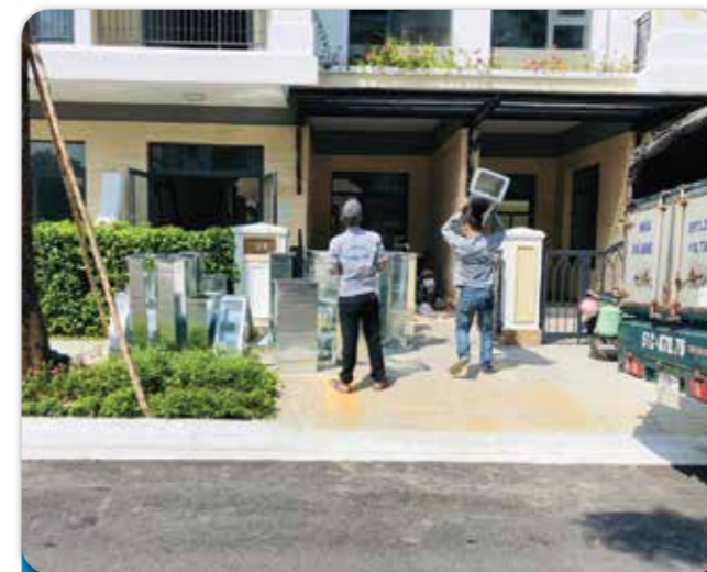
Dự án: THI CÔNG MÁY LẠNH TRUNG TÂM CHO BIỆT THỰ LIÊN KỀ
