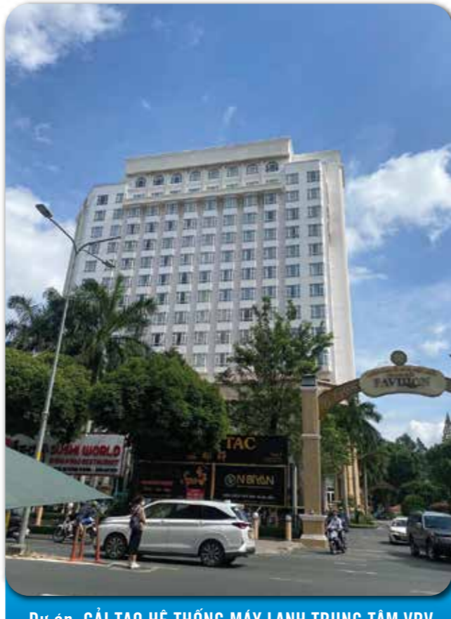
Dự án: CẢI TẠO HỆ THỐNG MÁY LẠNH TRUNG TÂM VRV 120HP - CHO TẦNG 3 KHÁCH SẠN TÂN SƠN NHẤT, PHÚ NHUẬN
