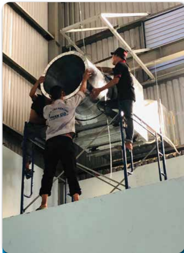
Dự án: CUNG CẤP THI CÔNG HỆ THỐNG THÔNG GIÓ NHÀ XƯỞNG
