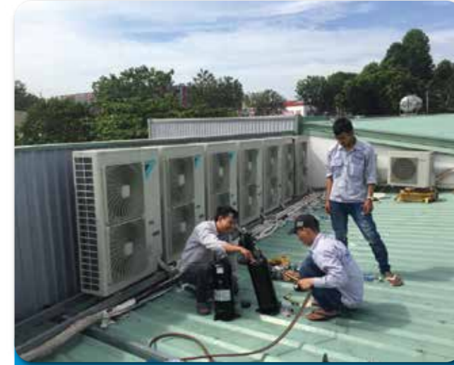
Dự án: DỊCH VỤ THAY MÁY NÉN, SỬA MÁY LẠNH ẨM TRẦN DAIKIN
