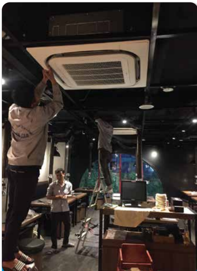
Dự án: CUNG CẤP LẮP ĐẶT MÁY LẠNH DAIKIN ẨM TRẦN CHO CHUỖI NHÀ HÀNG HOTPOT
