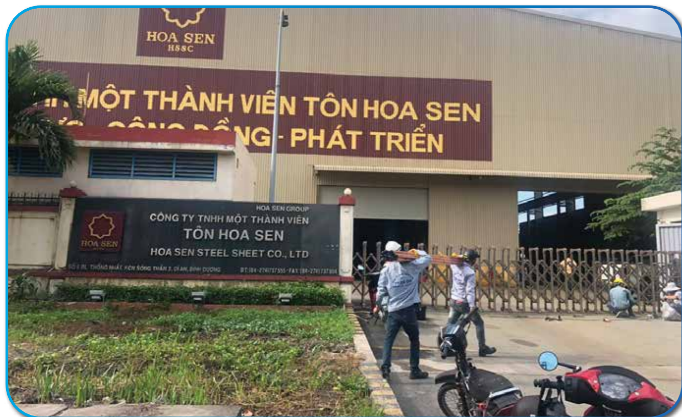
Dự án: CUNG CẤP, LẮP ĐẶT MÁY LẠNH PACKAGED CHO NHÀ MÁY TÔN HOA SEN - BÌNH DƯƠNG
