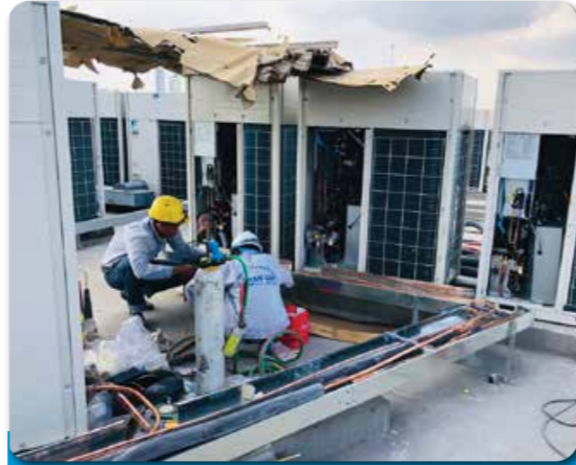
Dự án: CUNG CẤP, THI CÔNG MÁY LẠNH TRUNG TÂM VRV A CHO TRƯỜNG HỌC AIS, QUẬN 2
