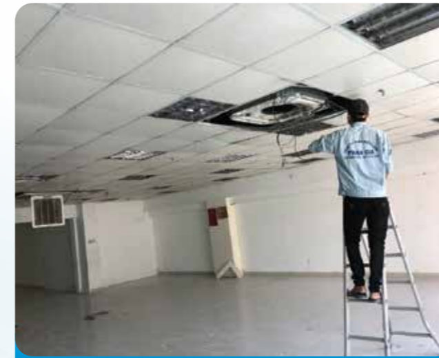
Dự án: BẢO TRÌ MÁY LẠNH TRUNG TÂM CHO TÒA NHÀ 27B NGUYỄN ĐÌNH CHIỂU, QUẬN 1
