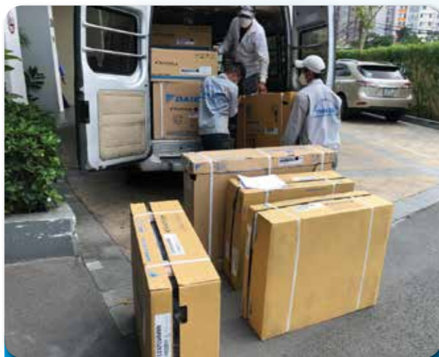
Dự án: CUNG CẤP, LẮP ĐẶT MÁY LẠNH GIẤU TRẦN, NỐI ỚNG GIÓ CHO CÁN BỘ TẠI QUẬN 2
