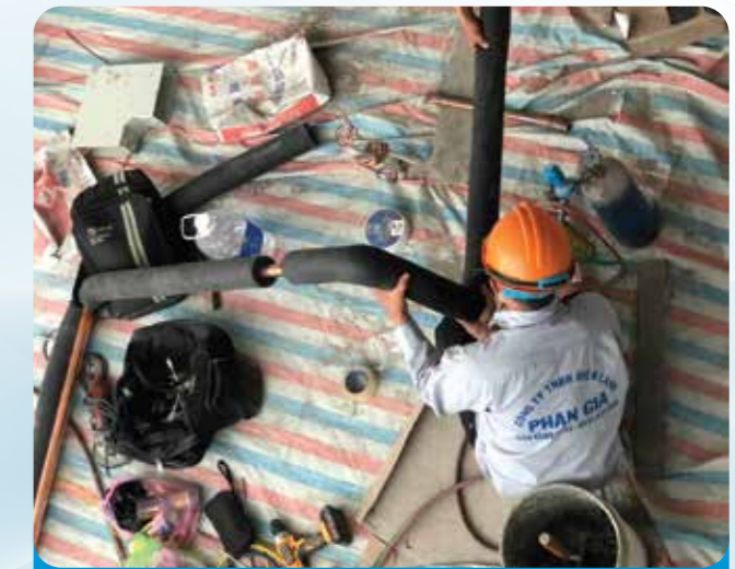
Dự án: THI CÔNG ỚNG ĐỒNG CHO HỆ THỐNG LẠNH TRUNG TÂM VRV
