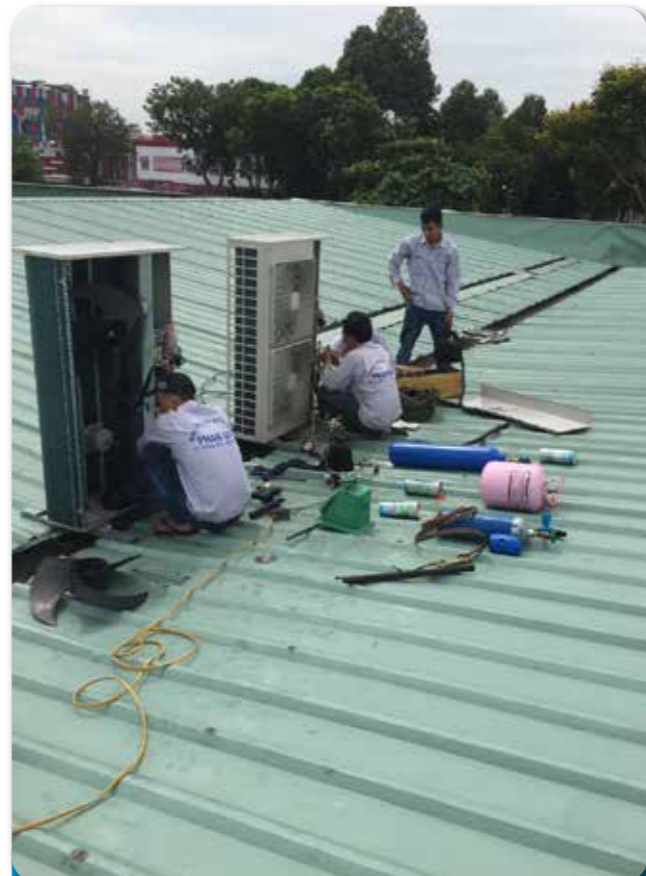
Dự án: SỬA CHỮA, THAY MÁY NÉN, MÁY LẠNH ẨM TRẦN CHO SHOWROM ÔTÔ ANYCAR VIỆT NAM
